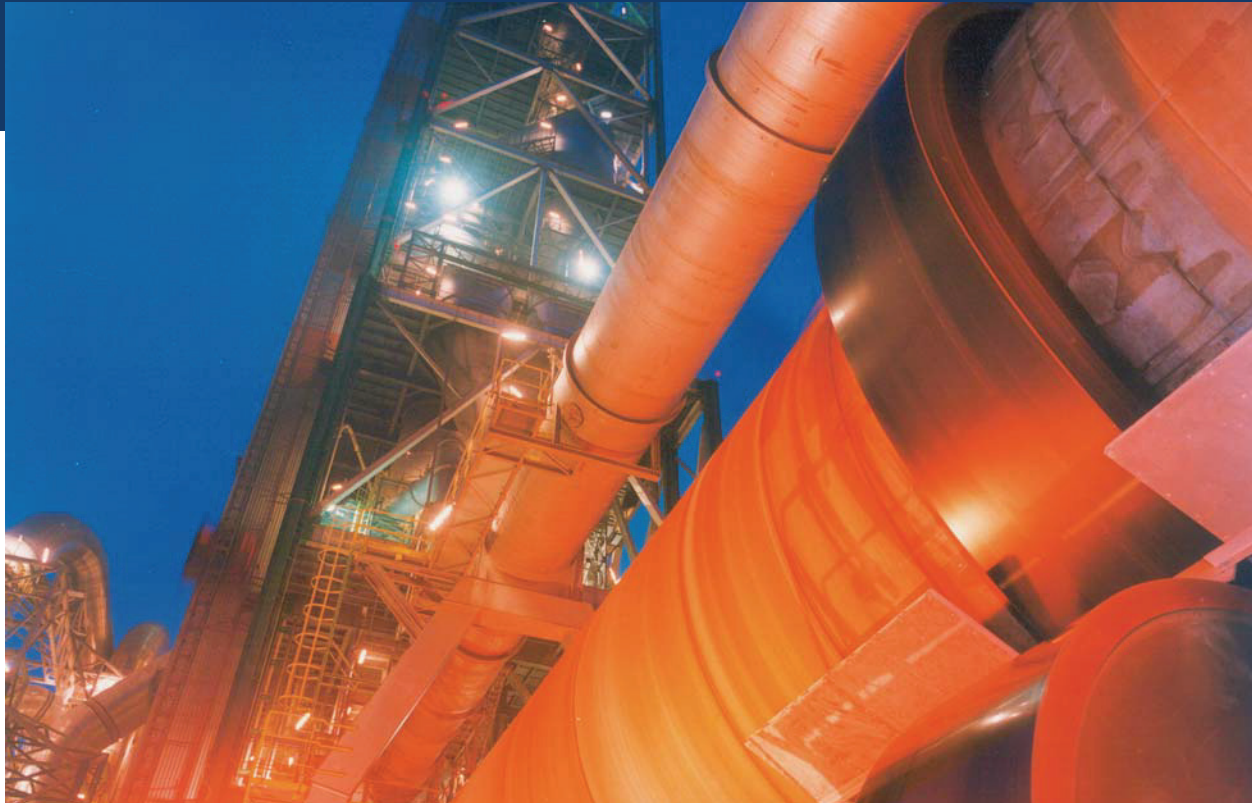
Vorwärmerturm mit Drehrohröfen einer Zementfabrik
