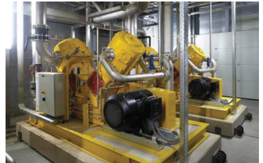
trockenlaufender V1-Kompressor für CO 2 -Rückgewinnung im Braubereich
