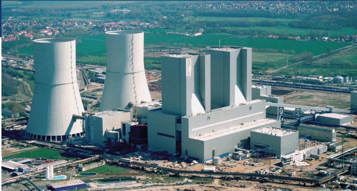
Braunkohlekraftwerk Lippendorf, Deutschland
