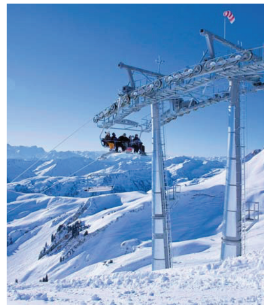
Stützengruppe mit Rollenbatterien und Fahrzeug in einer Umlaufseilbahn Typ 6-CLD
