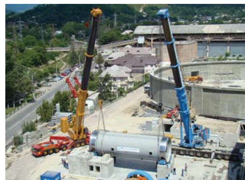
Ansicht einer Baustelle mit Kugelmühle
